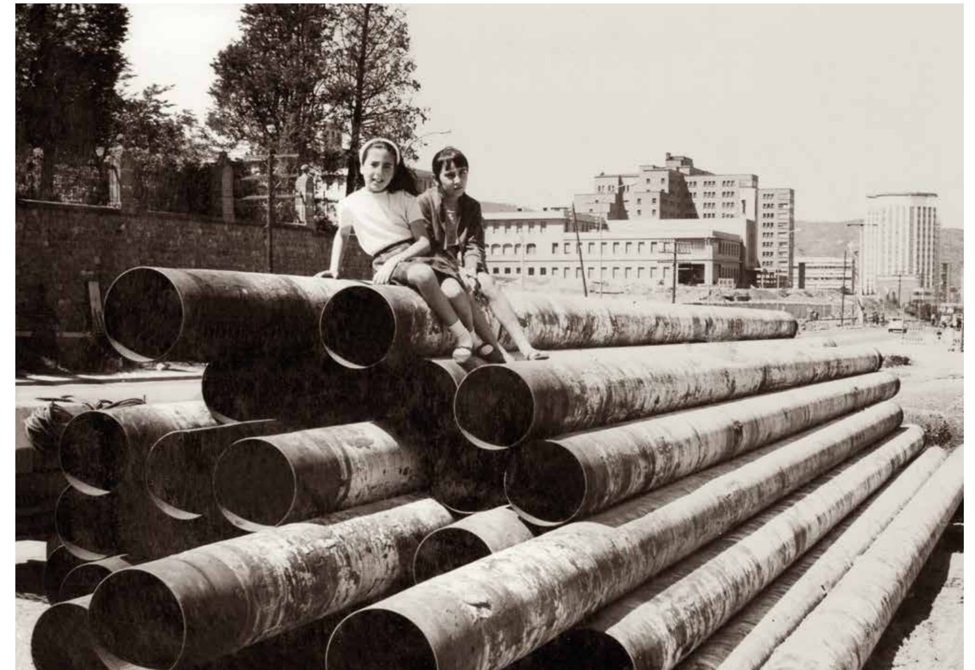
↗ Loli i Isabel Notó al passeig de la Vall d'Hebron l'any 1967. Darrere d'elles, el mur del Patronat Ribas, l'Hospital de Sant Rafael, la residència de la Vall d'Hebron i l'Hospital maternoinfantil en construcció. José M. Notó. Cedent: Isabel Notó Igual
